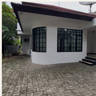
Renovasi – Fasad Rumah
